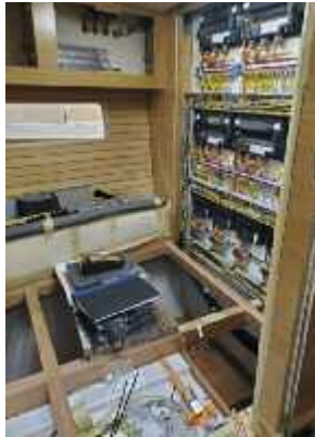
Nur einer von mehreren Einbauten auf der HR 69
